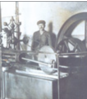
Napędzająca zwierzyniecki browar maszyna parowa.
